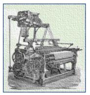
3.)No ano de 1784, baseado na introdução de equipamentos mecânicos de produção acionados por água e/ou vapor, nasce o primeiro Tear mecânico, para produção em escala industrial. Ano provável de início da primeira revolução industrial. Para evitar creditar a determinado projeto este marco histórico, podemos dizer que aconteceram iniciativas industriais nos últimos 20 anos do século XVIII.
